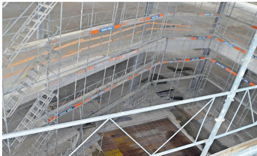
Herzstück im Möbel-Pfister-Teil: Das Atrium, hier der Blick von oben.
