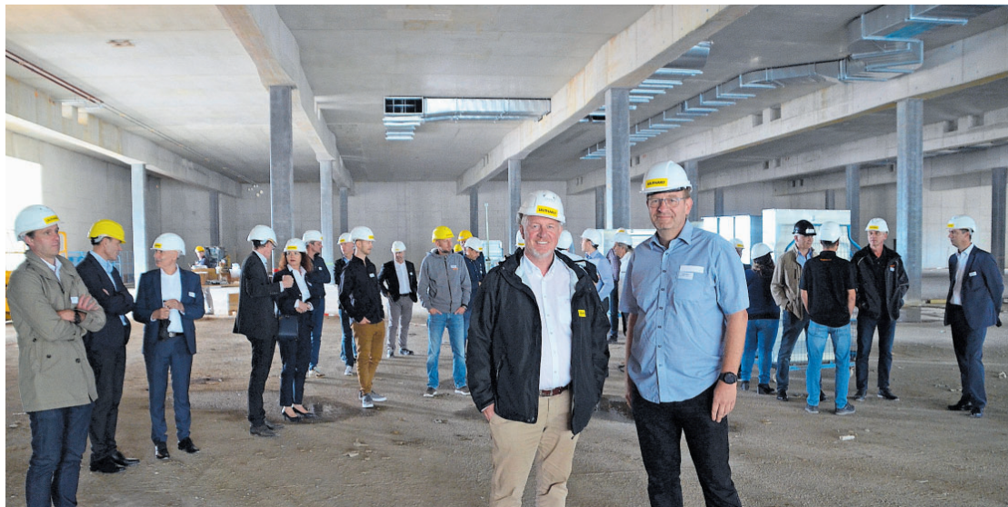
Projektleiter Henner Moor (rechts) und Leuthard-CEO Dieter Greber führen die Ämtler Arbeitgeber durch die Grossbaustelle «Albis-Park». (Bilder Thomas Stöckli)
